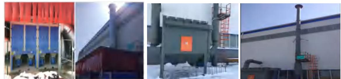
焊接废气净化设施和排气筒
