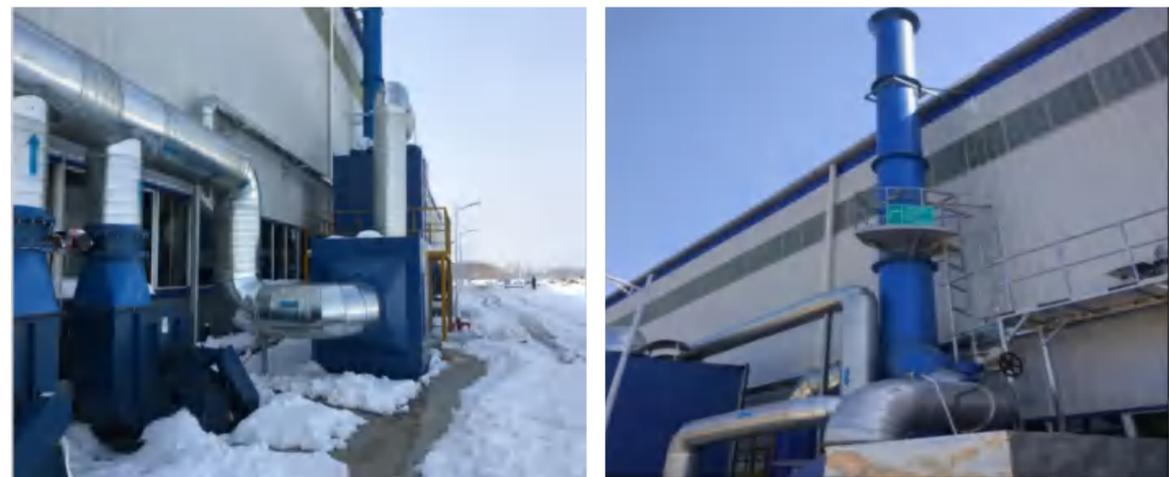
喷漆废气净化设施和排气筒
